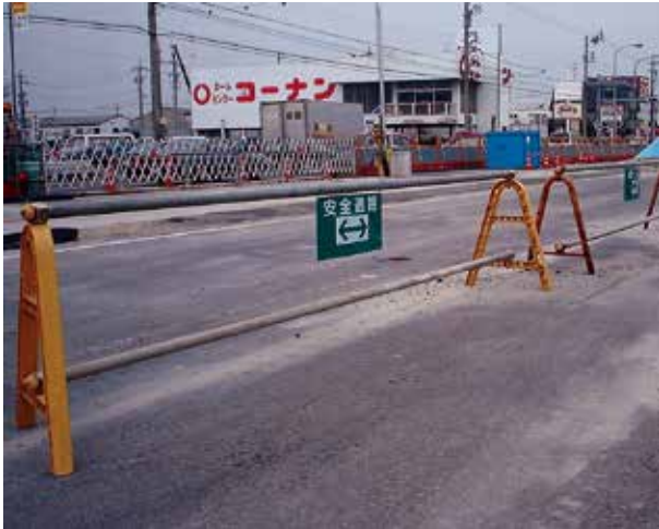
安全通路設置状況
