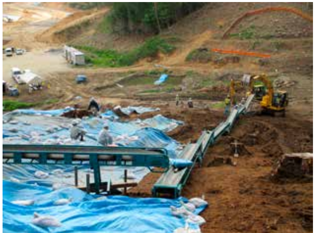
ベルトコンベアの設置例
