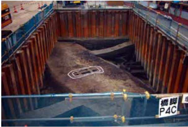
シートパイル 朝日遺跡
