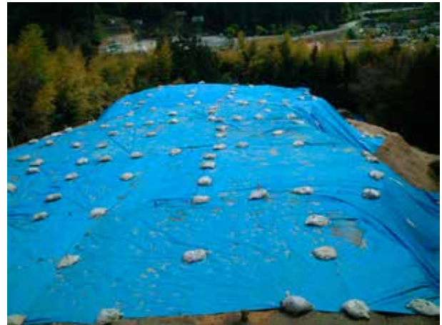
シート設置状況
