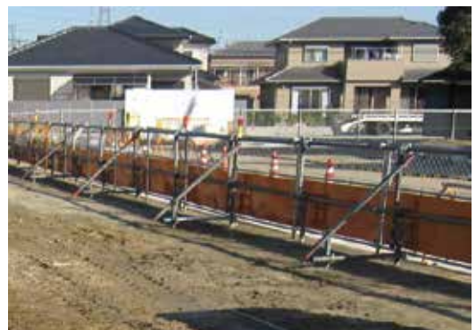
フェンスの設置例
