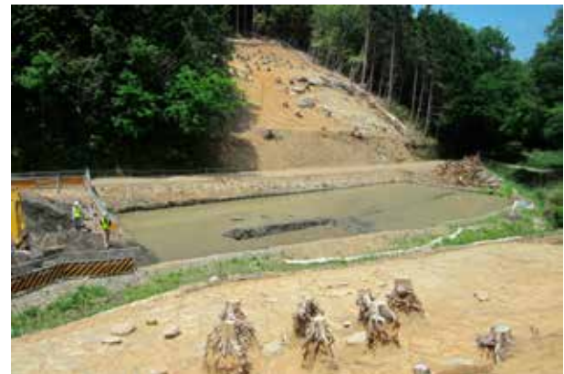
沈砂池の状況
