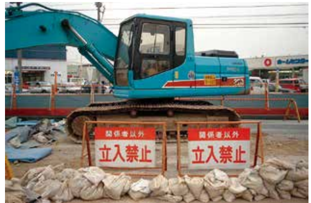
重機作業半径立入禁止
