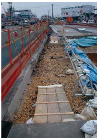
通路棧橋設置
