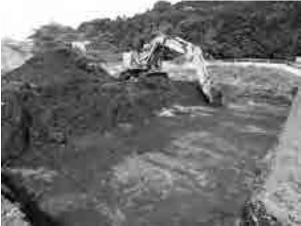
重機による表土掘削
