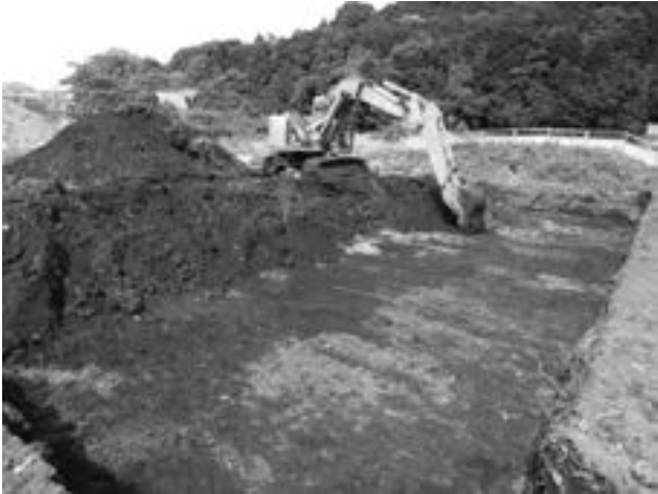
重機による表土掘削
