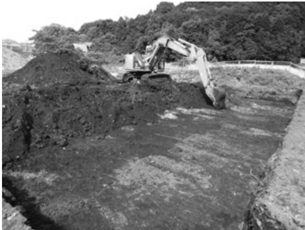
重機による表土掘削
