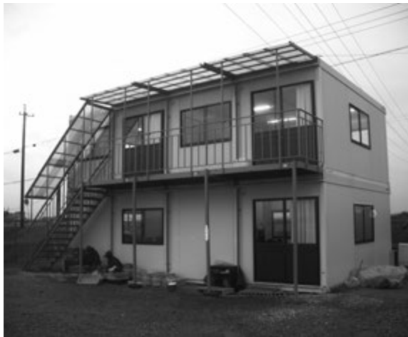
監督員ほか詰所（2階）と作業員休憩所（1階）
