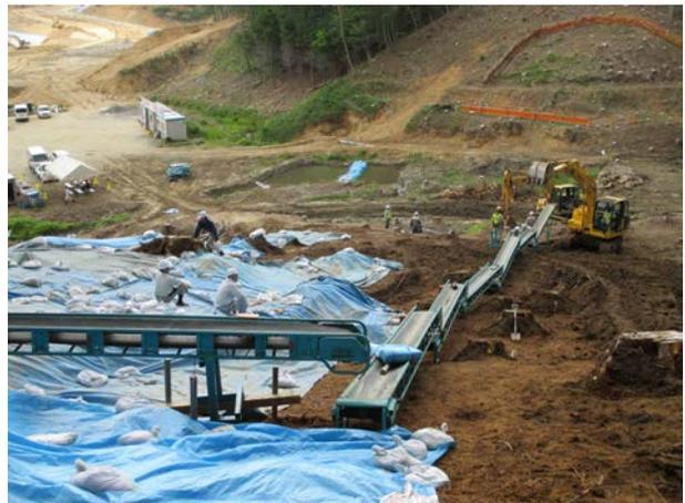
ベルトコンベアの設置例
