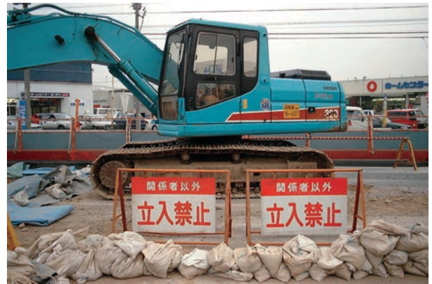
重機作業半径立入禁止
