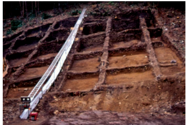
シューター設置状況
