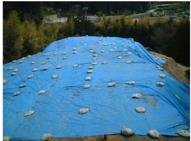
シート設置状況
