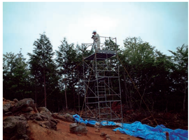
ローリングタワー
