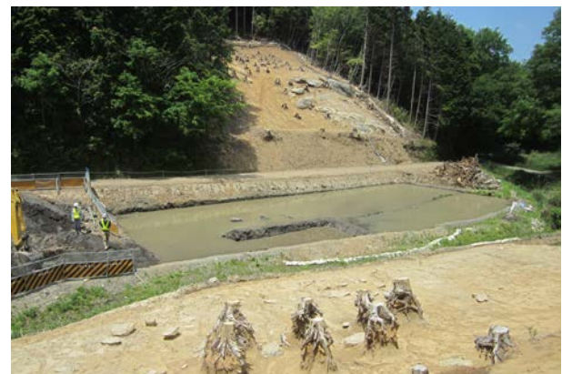
沈砂池の状況
