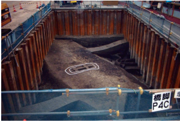
シートパイル 朝日遺跡
