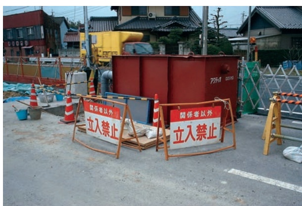
ノッチタンクの設置状況
