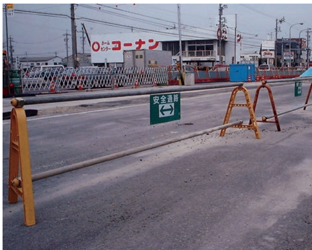
安全通路設置状況
