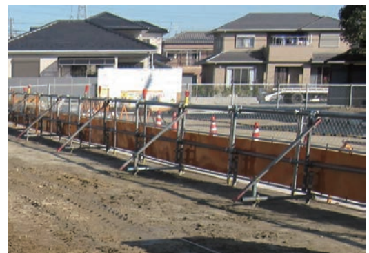
フェンスの設置例
