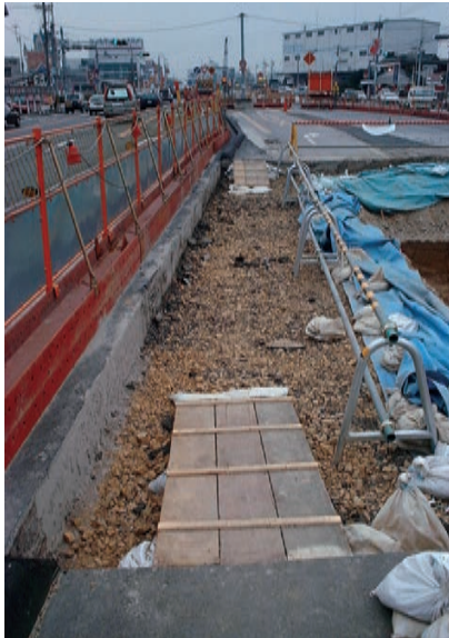
通路棧橋設置
