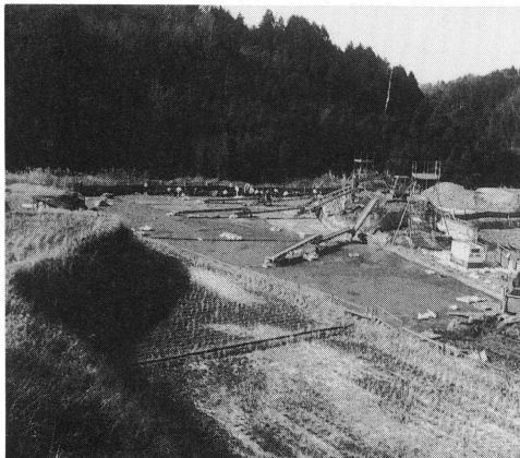
調査区全景（東より）
