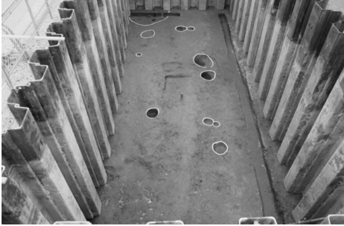
D区遺構完掘状況（北より）
