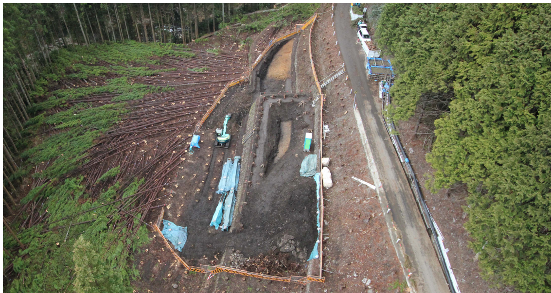
調査区遠景（東側上空から撮影）
