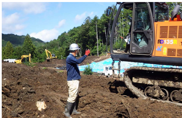
写真8 重機運転手への安全指示
