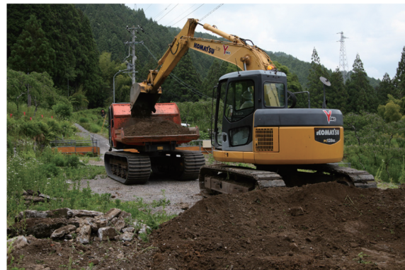
写真1 重機・キャリアダンプでの掘削風景
