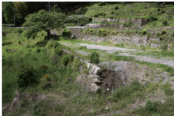
写真2 調査前(北側方向より)
