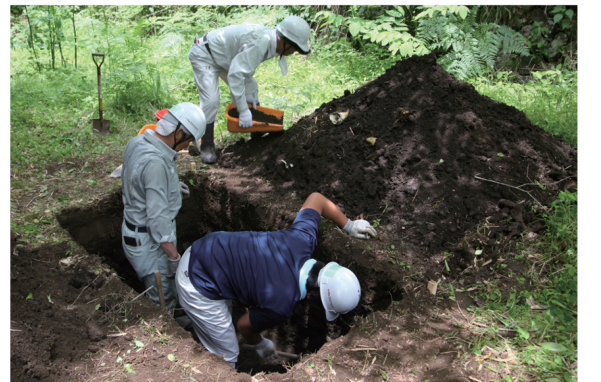
写真1 人力での掘削風景
