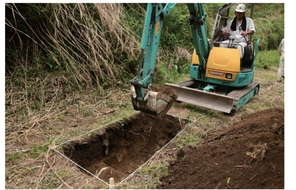
写真2 重機での掘削風景
