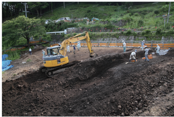
写真3 表土掘削中(北側方向より)
