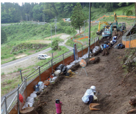
写真7 発掘調査状況
