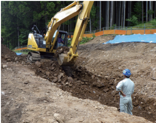
写真5 19A区表土掘削状況
