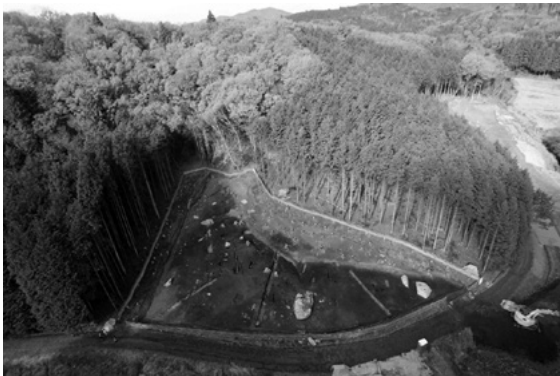
B区全景(西より)
