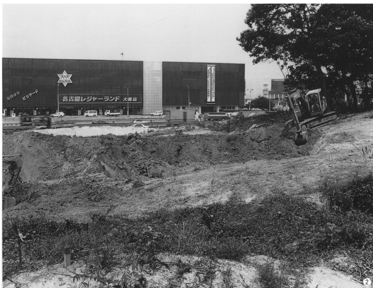
①調査前風景（西より） ②表土剥ぎ（東より）
