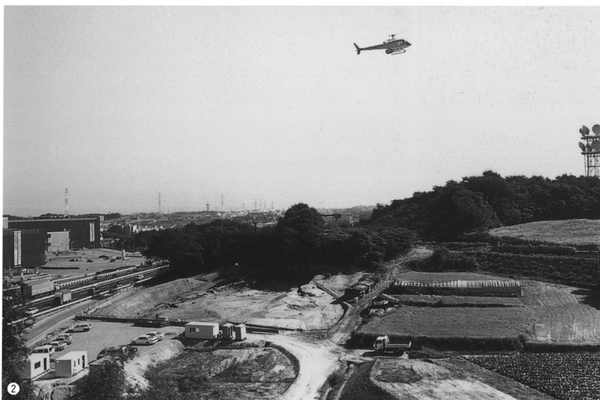
①調査区全景（北西より） ②航空測量風景（西より）
