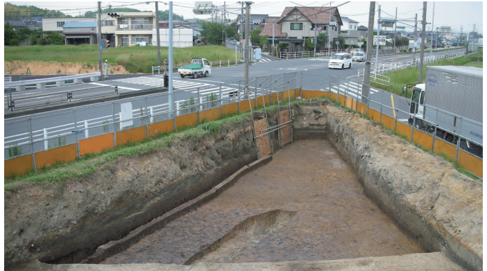
07区北半部谷地形001SX完掘状況（南から）。
