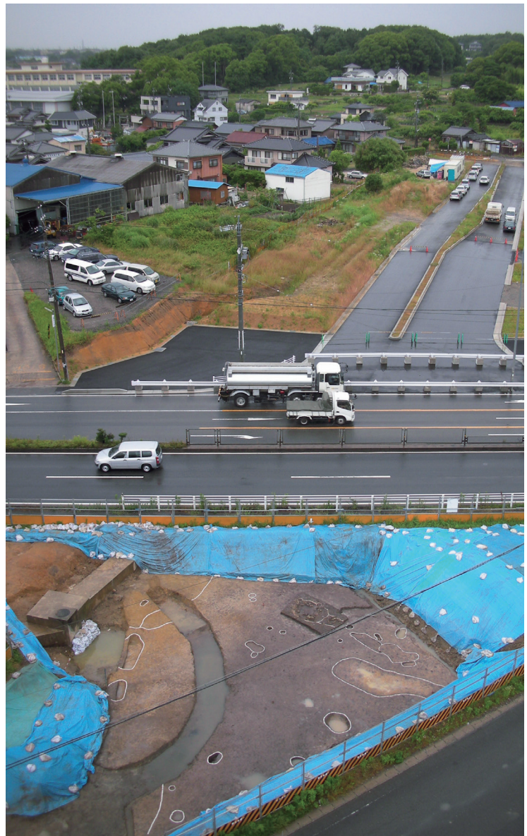
07区検2面全景および06区調査終了状況（南東から）。
