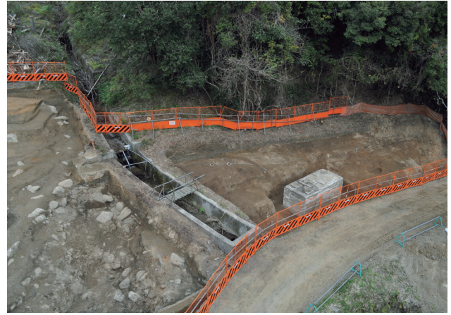
10Ab 区 1 面全景 (南より)
