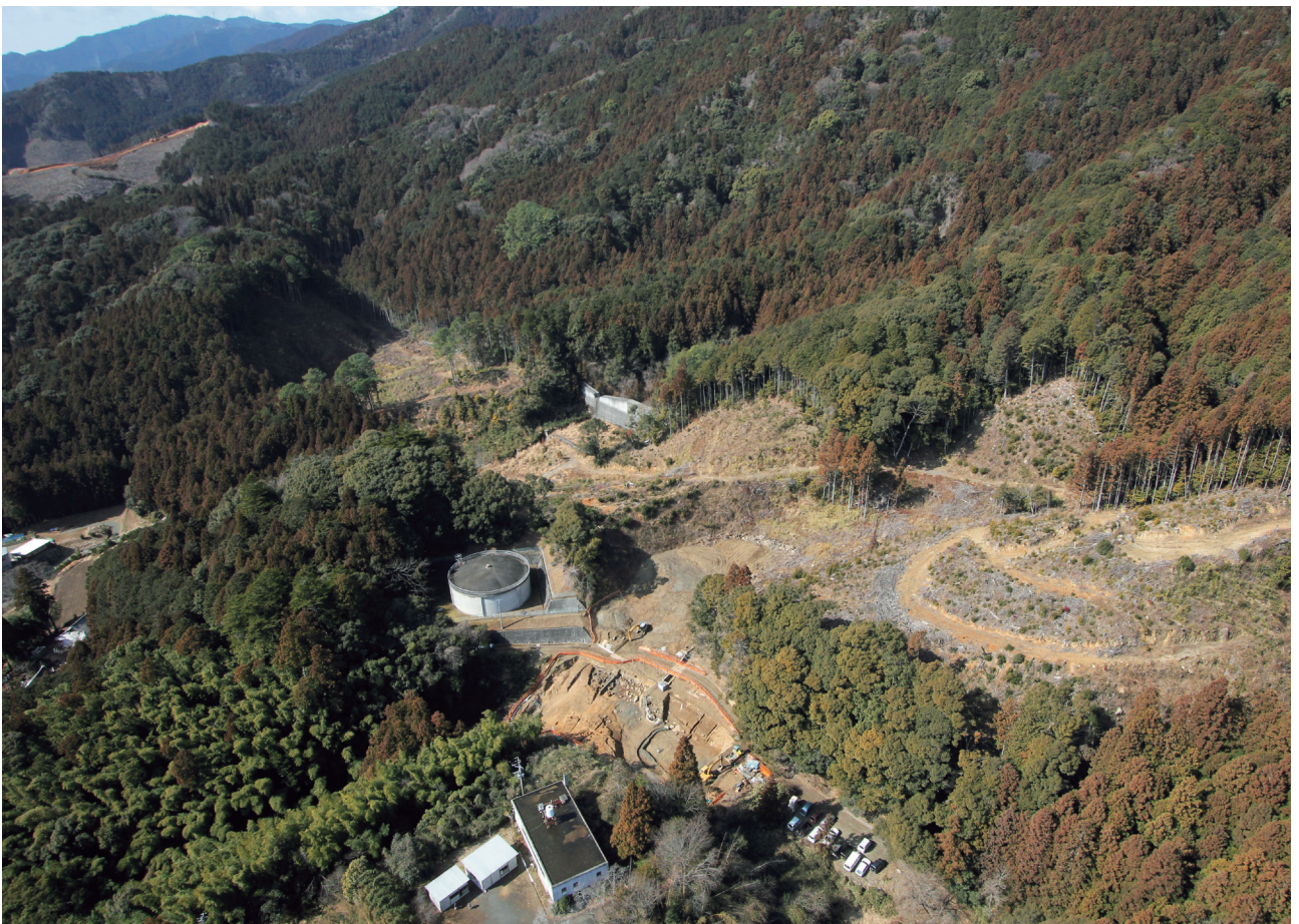
欠下城跡全景（南東より）
