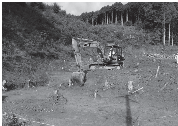
発掘1 表土掘削(10Aa区、南東より)
