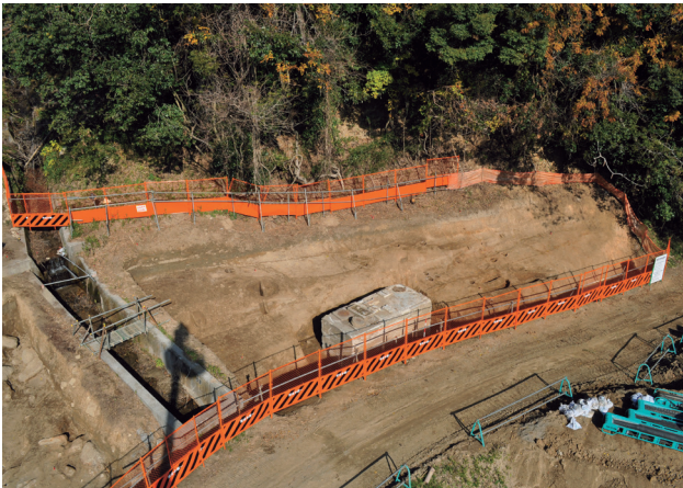
10Ab 区 2 面全景 (南より)
