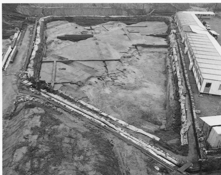
95B区 NR201 南から
