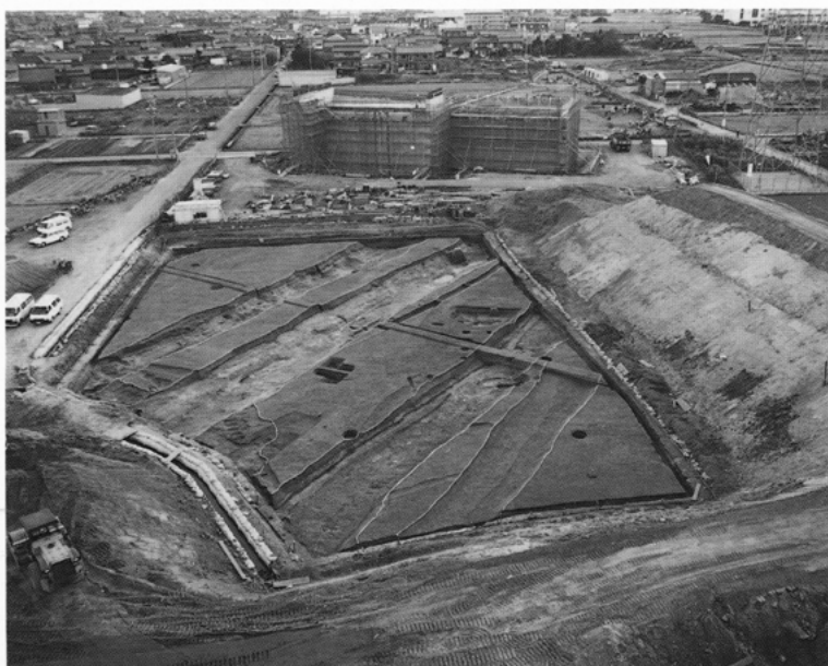
古代 大溝群全景 95Ab区 北から
