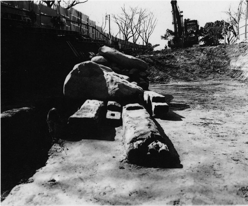
◀SX01 C地点石垣 (94A区北から)
