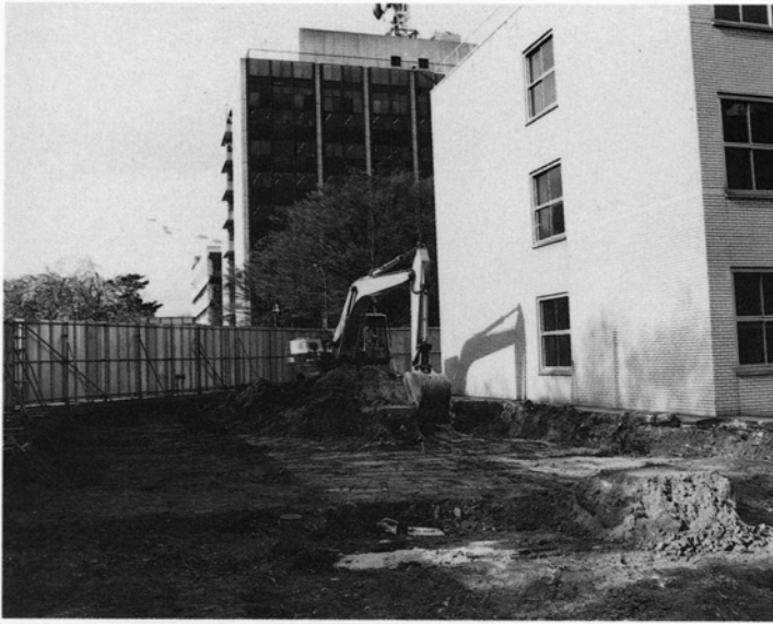
①表土剥ぎ風景
