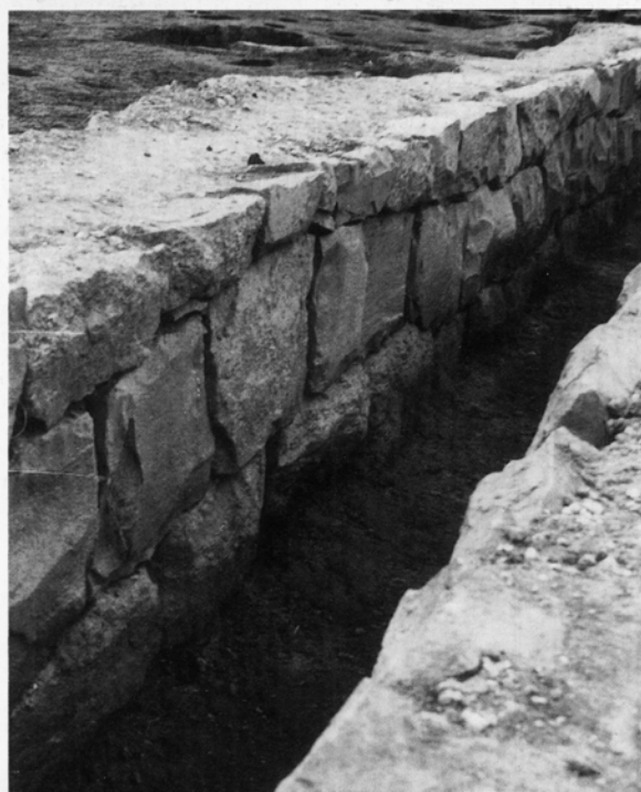
5 ▶ 暗渠側面 (東側)
