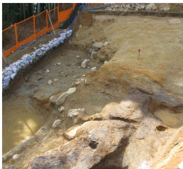
築山撤去 東より
