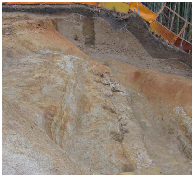
299SD (古)・309SX 北より
