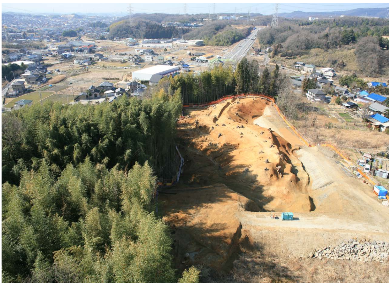
08区完掘全景 東より
