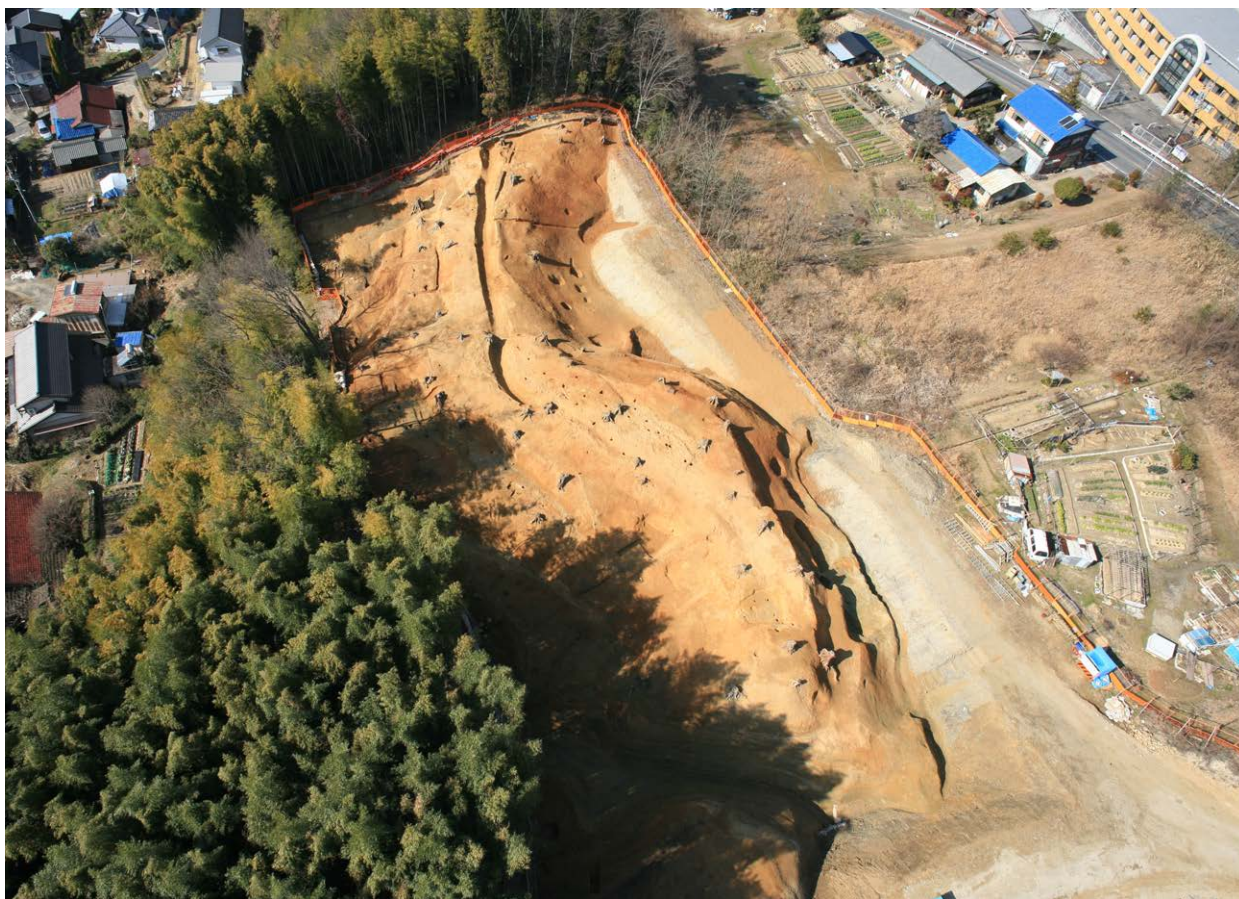
08区完掘全景 東より
