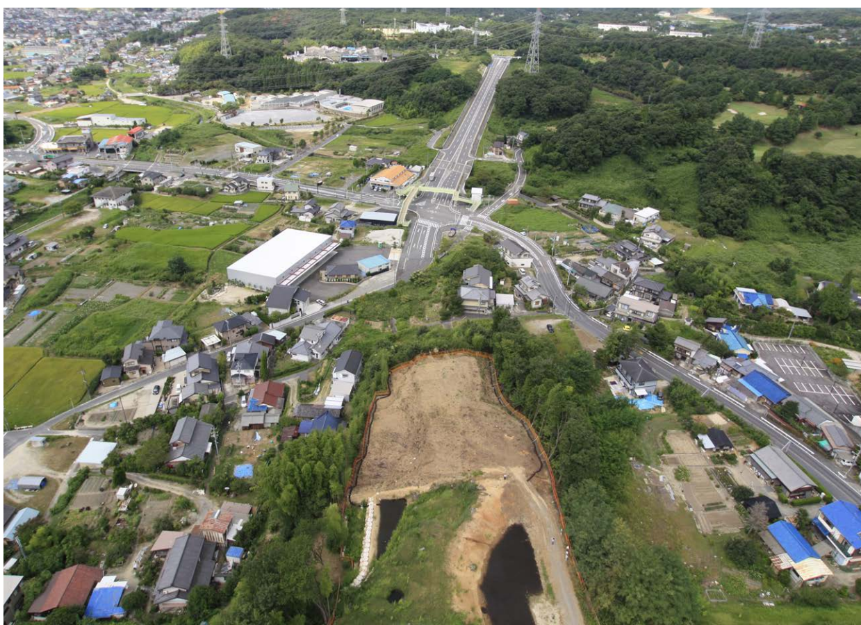
09 区調査前 全景 東より
