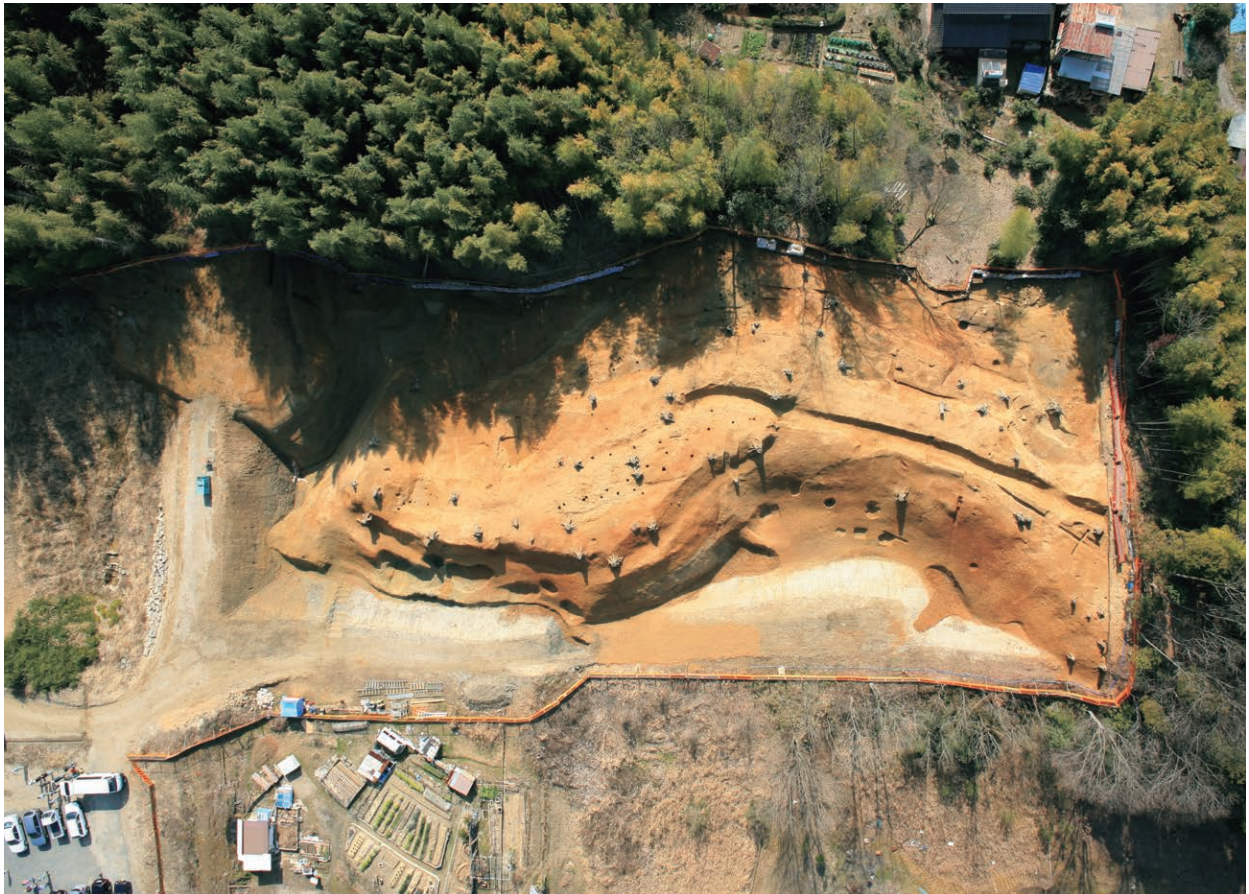
08区 全景 北方向より
