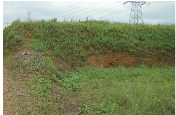
調査着手前の状況（窠体付近）
