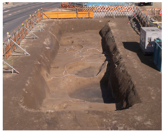
Ab区全景（南より）
