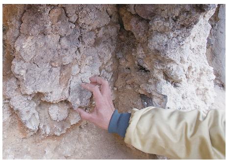
写真 1 001SY 窯体壁補修状況
