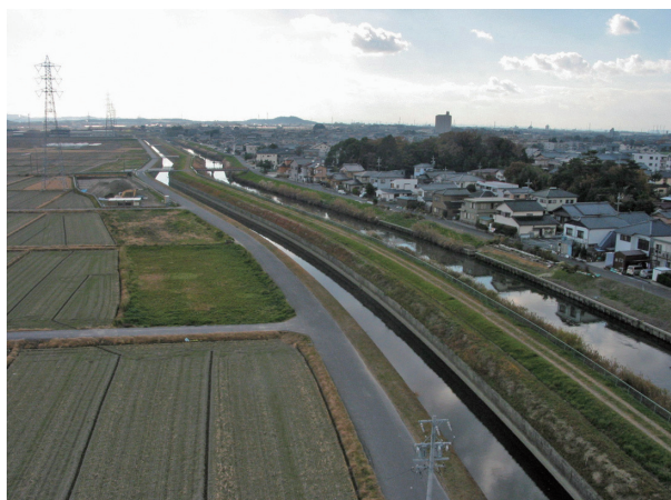
05A 区 2 面から南を望む（北より）
