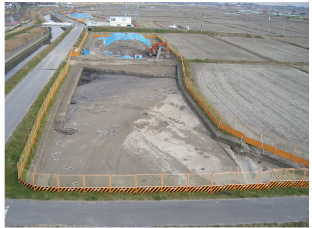
06C区3面全景(南より)
