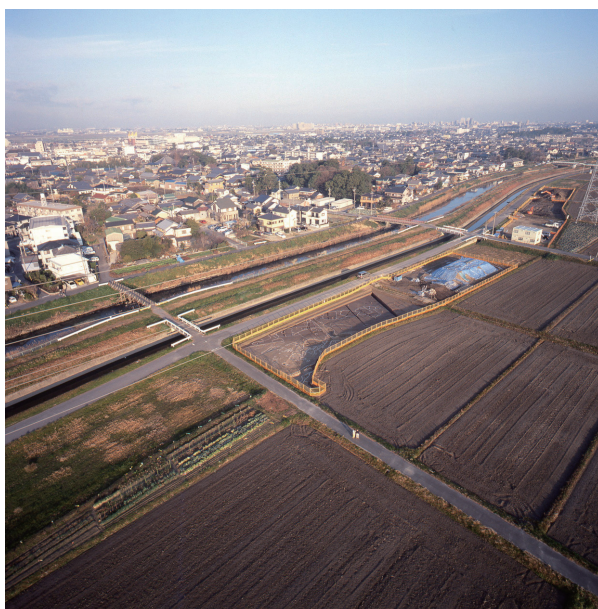
06C 区 2 面から北西を望む（南東より）
