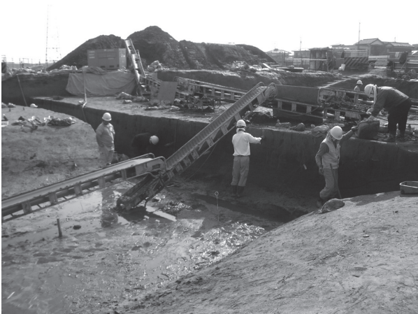
写真2 05B区 NR01 調査風景
