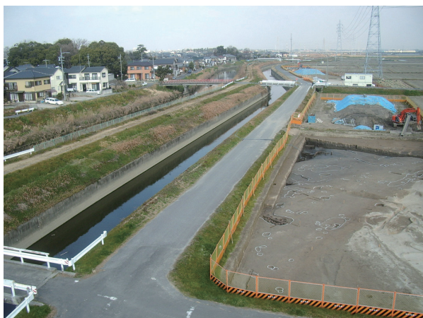
06C 区 3 面から北を望む（南より）
