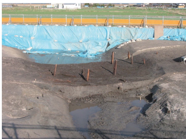
05B区 NR01 南北ベルト部分杭検出状況 (西より)
