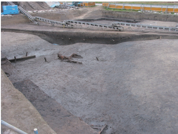
05B区NR013 層掘削状況（北東より）
