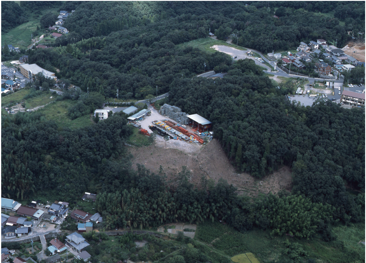
調査前遠景 南より
