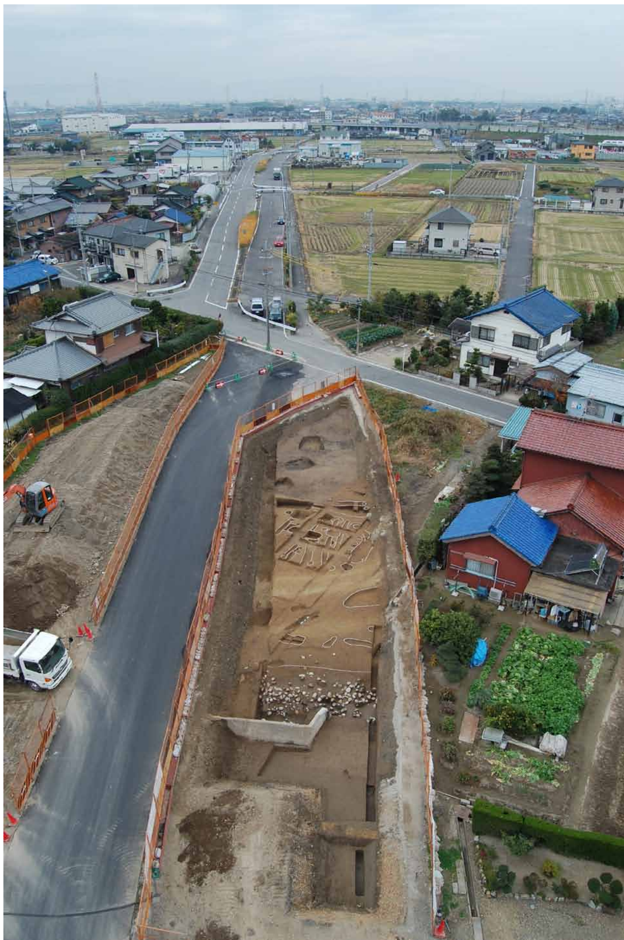
07E 区 1 面全景 東から
