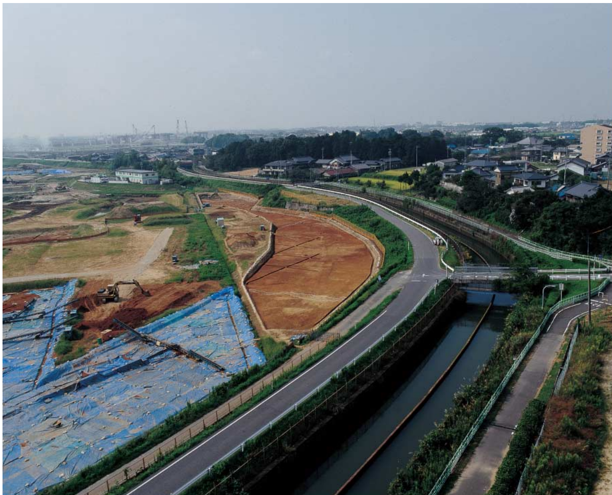
99F 区全景（北から、手前は明治用水奥の森が糟目春日神社）
