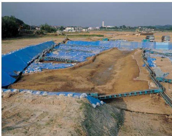
99ASD01 第1層完掘状況（南西から）
