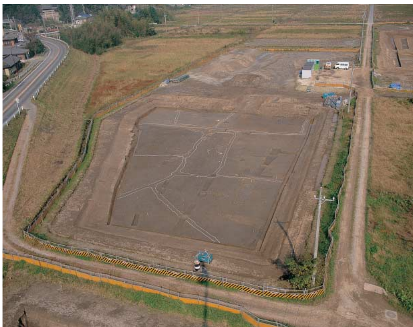
98B1 区全景 (近世～近代の水田遺構面、南から)
