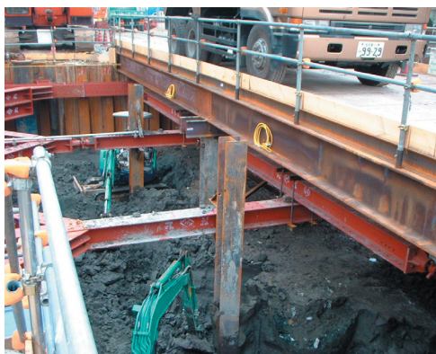
P78工区調査風景
