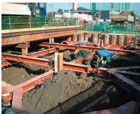
P81工区調査風景
