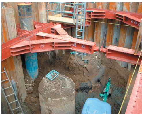
P83工区調査風景 1
