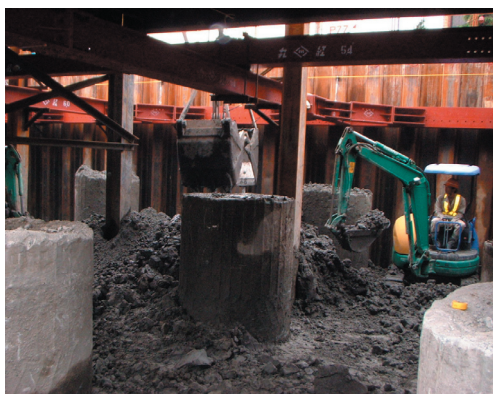
P77工区調査風景
