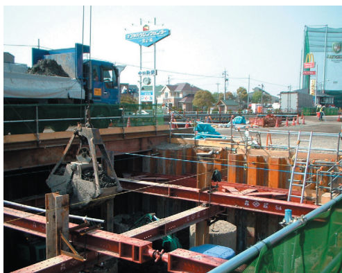
P80工区調査風景
