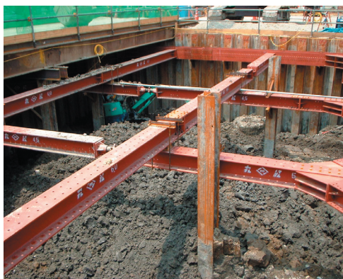
P70工区調査風景
