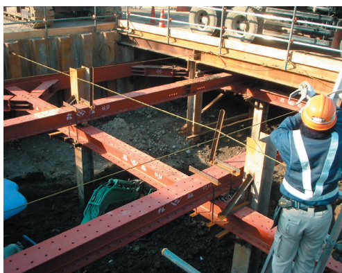
P82工区調査風景
