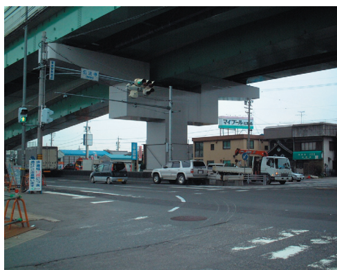
伝法寺本郷遺跡調査完了後（伝法寺交差点）
