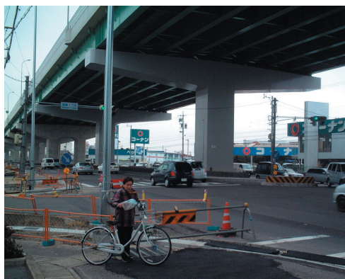
島崎遺跡調査完了後（島崎1丁目交差点）
