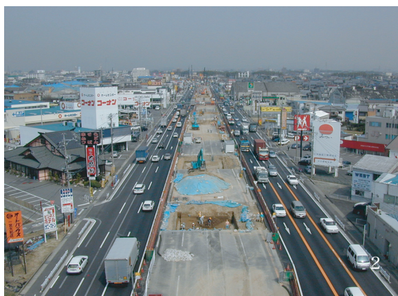
写真6 調査区遠景（1：J区から南を、2：A区から北を）
