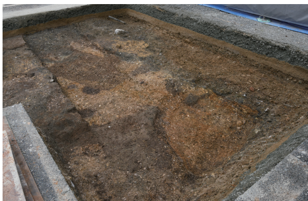
22B 区遺構検出状況（北西より）
