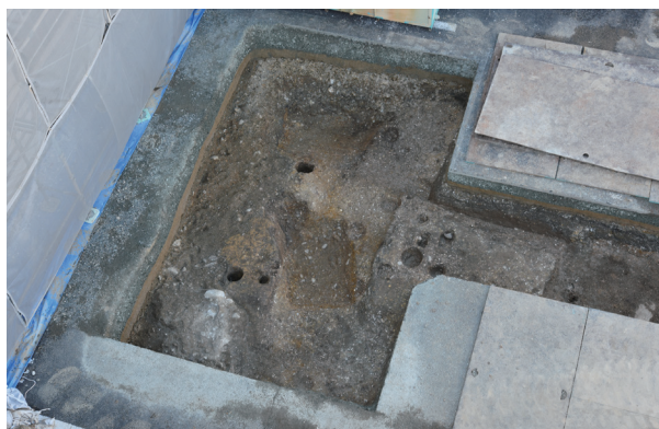
22B 区完掘状況（北東より）
