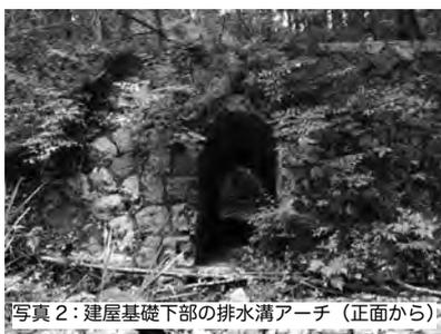
写真2：建屋基礎下部の排水溝アーチ（正面から）
