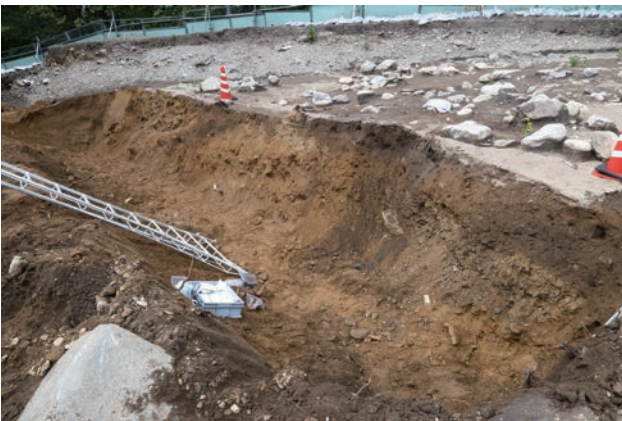
A区1トレンチ北側深掘り断面(南東から)
