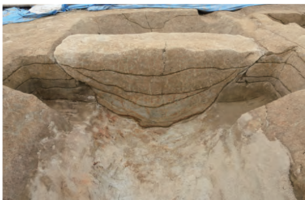
18A区 001SD・006SD 断面（東より）
