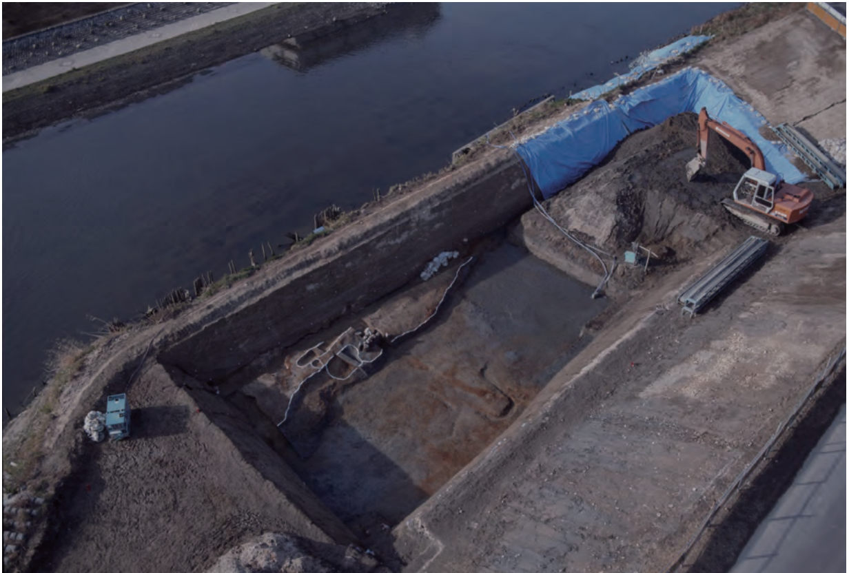
00A 区全景（南東より）
