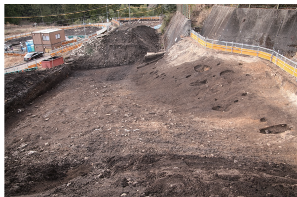
14A区 西側全景 (東より)
