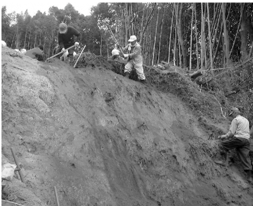
A区 作業風景(南から)
