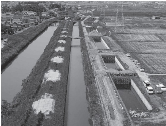
23B・C・E区全景 (北から)
