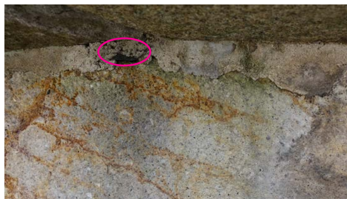
図2 北側四層軸と笠の間に敷かれている鉄板 (赤く囲っている箇所はモルタルの隙間から確認できる鉄板)
