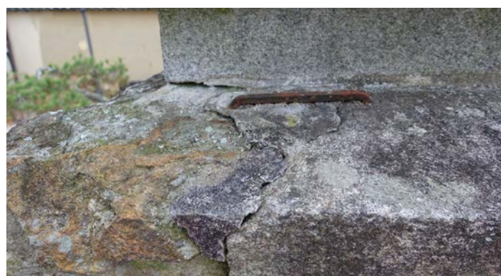
図3 凝灰岩と花崗岩の部材を接着している四層笠(北から撮影)
