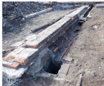
25 Ag 区 1 面目 愛知一中基礎 【明治時代】 基礎のそばには土管とコンクリートの樹によって作られた排水施設も見つかりました。
