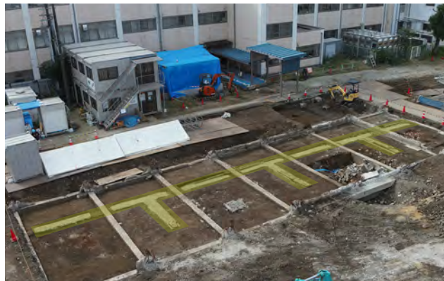
25 Ag 区 1 面目 愛知一中基礎【明治時代】（北東から） 明和高校北校舎基礎の下から見つかりました。レンガ積みとコンクリートによって作られています。奥は明和高校の校舎。
