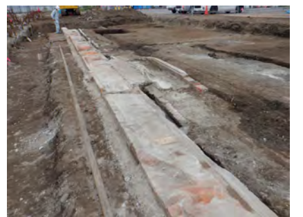
25Ah 区 愛知一中の基礎（東より） レンガ積みによって構築されています。
