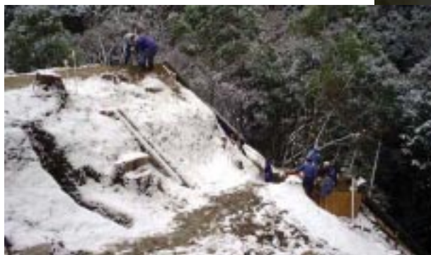
雪の日の作業（00A 区）
