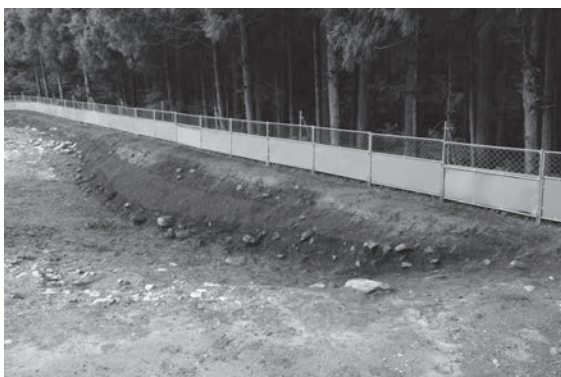
20Ac区西壁面400NR部分
