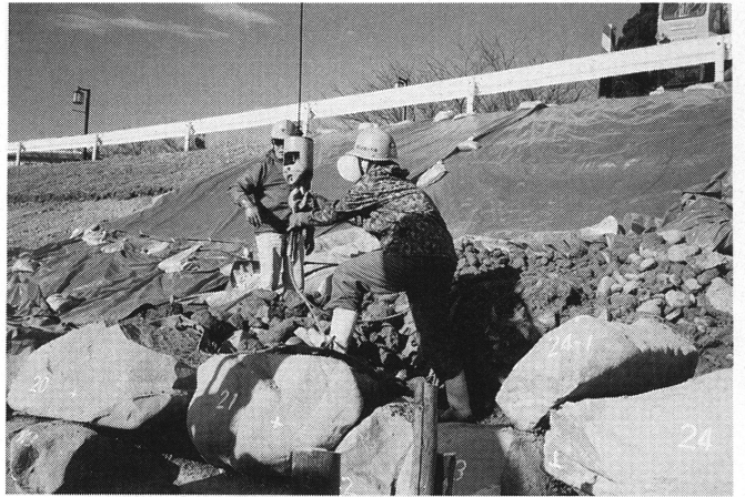
写真2 石垣の取り上げ
