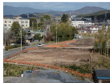
▲調査区 遠景（南より）
