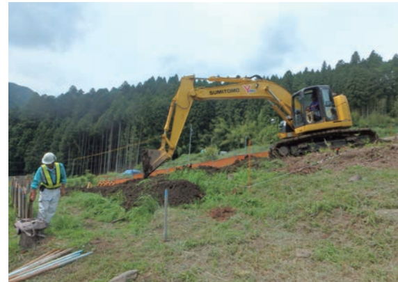
写真5 18B区表土掘削（南東から）
