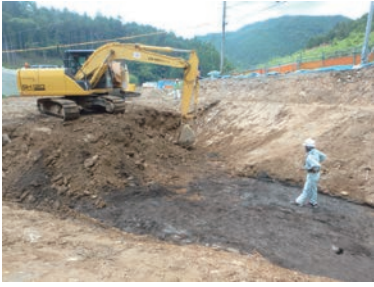
写真9 表土掘削風景 (東から)
