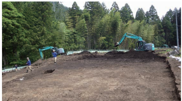
写真9 笹平遺跡 重機（バックホー）を使った表土掘削
