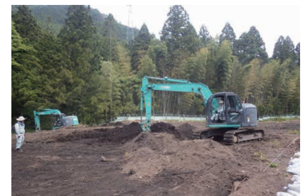
写真2 表土掘削風景
